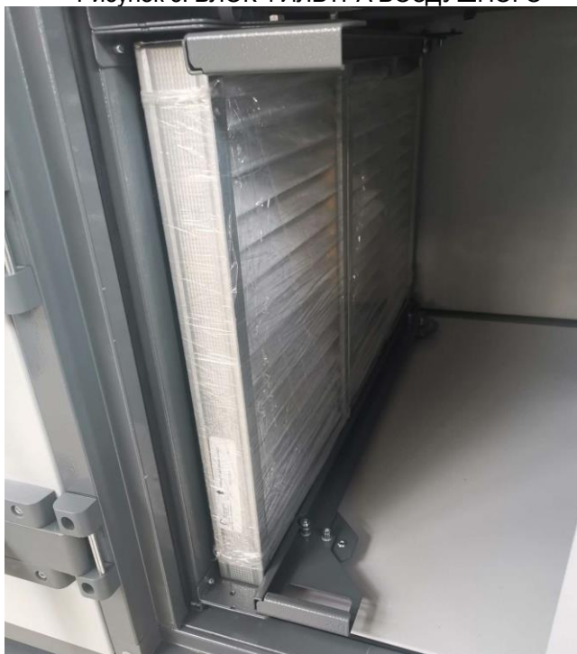
Рисунок 6. БЛОК ФИЛЬТРА ВОЗДУШНОГО
